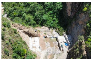
CONST. REPRESA VALLE DE TIN Y SISTEMA DE RIEGO PRESURIZADO MIZQUE LOTE 1 (PRESA)
