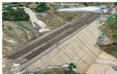
CONSTRUCCIÓN REPRESA ANGOSTURA (OMEREQUE)
