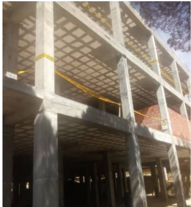
Construcción del bloque principal en el año 2023
