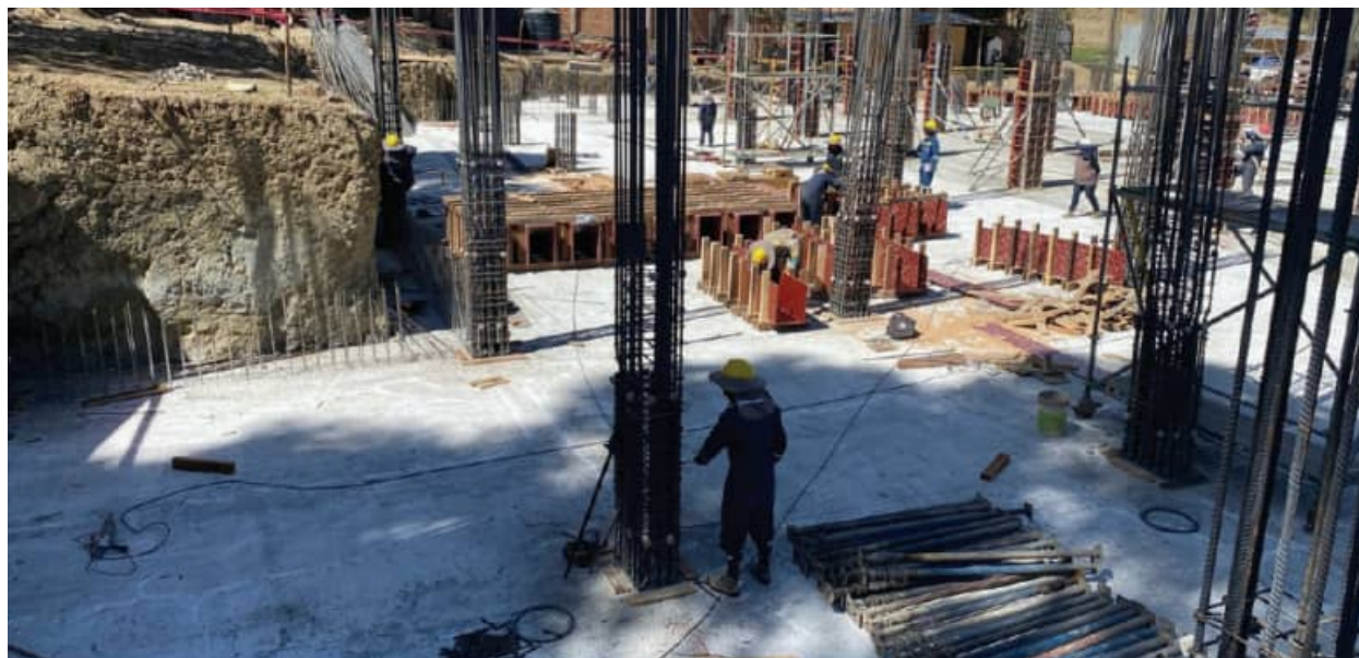
Armado de pilares de las oficinas de IBMETRO en Achocalla
