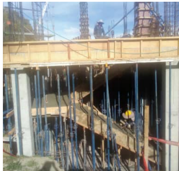
Construcción del segundo piso del bloque principal
