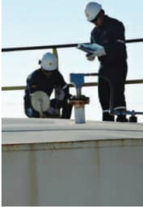
Prueba hidráulica a tanque estacionario
