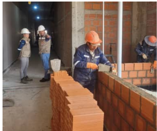
Proceso de construcción de los nuevos laboratorios
