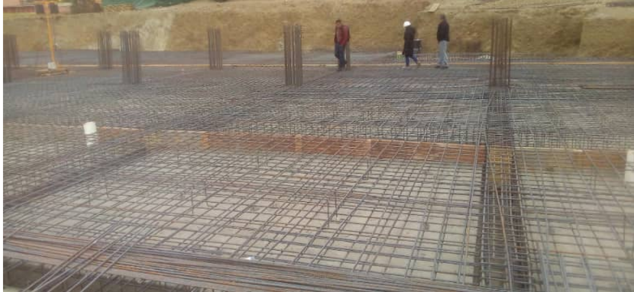
Construcción de la losa radier de fundación
