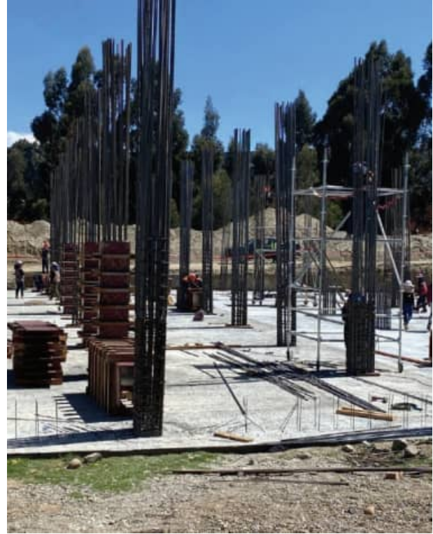
Construcción del primer piso del bloque principal
