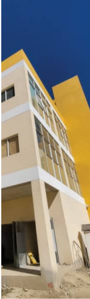
Proceso de construcción de laboratorios y oficinas de IBMETRO en Achocalla
