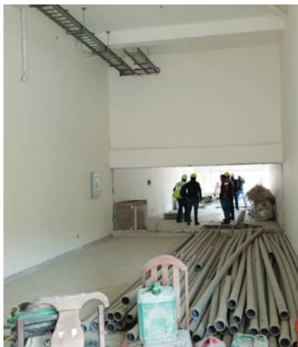
Fase final de la construcción de los laboratorios
