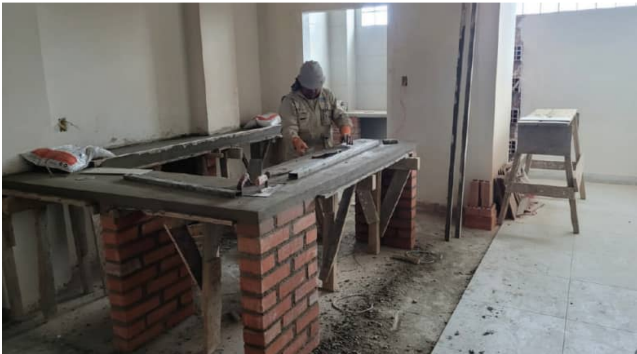
Imagen del proceso de construcción de la obra
